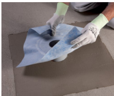
Pose d'un drain vertical sur Mapelastic
