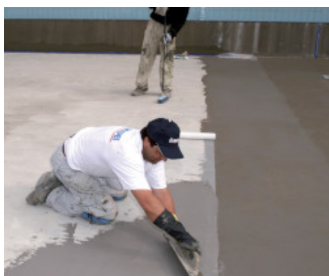
Imperméabilisation d'une piscine avec Mapelastic
