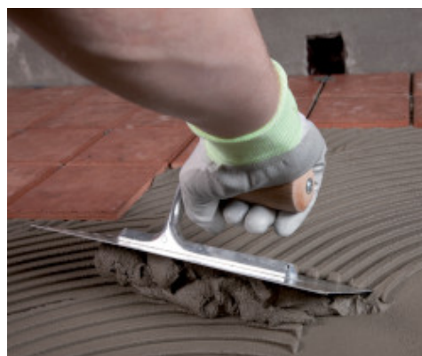
Mise en œuvre de Granirapid sur Mapelastic
