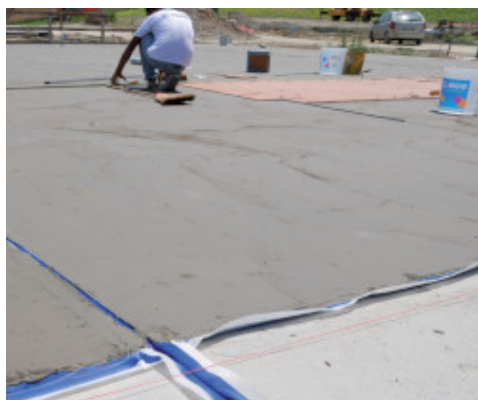
Imperméabilisation des supports avec Mapelastic et Mapeband
