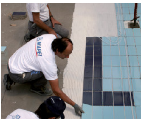
Pose d'un revêtement céramique sur Mapelastic
