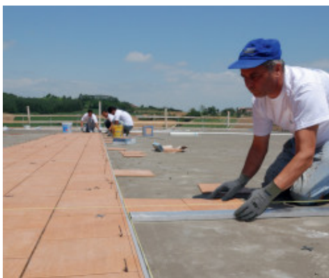
Pose de carrelage avec Kerabond + Isolastic
