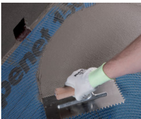
Application d'une couche de Mapelastic sur Mafenet 150
