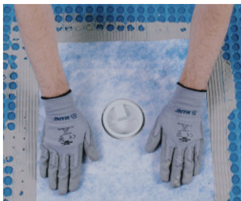
Imperméabilisation de l'écoulement avec Drain Vertical/Drain Lateral
