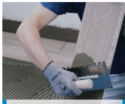
Pose de carrelage ou de pierre naturelle avec un mortier colle MAPEI adapté de classe C2 au minimum
