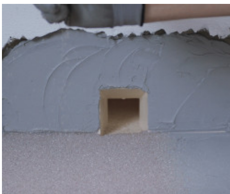
Imperméabilisation de l'écoulement avec Drain Front
