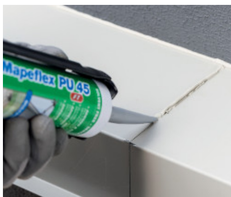
Jointolement élastique de joints de constructions
