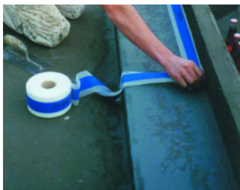
Imperméabilisation de la jonction entre le support et le bassin avec Mapeband.
