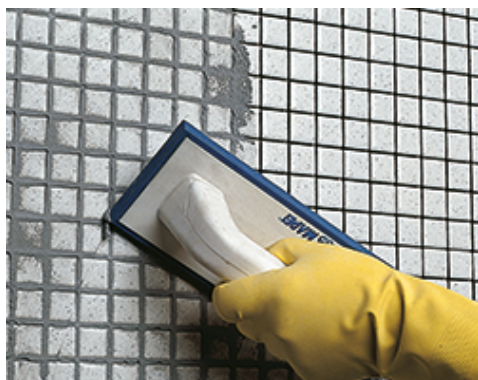
Remplissage des joints entre carreaux de pâte de verre à la spatule, dans une salle de bains
