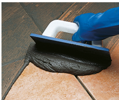
Jointoiement entre carreaux de grès émaillé, à la spatule
