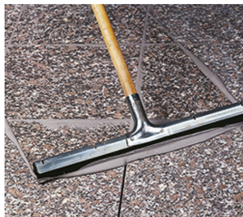
Jointoiement de granit à la raclette
