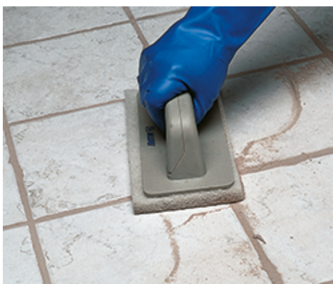
Finition au Scotch-Brite®
